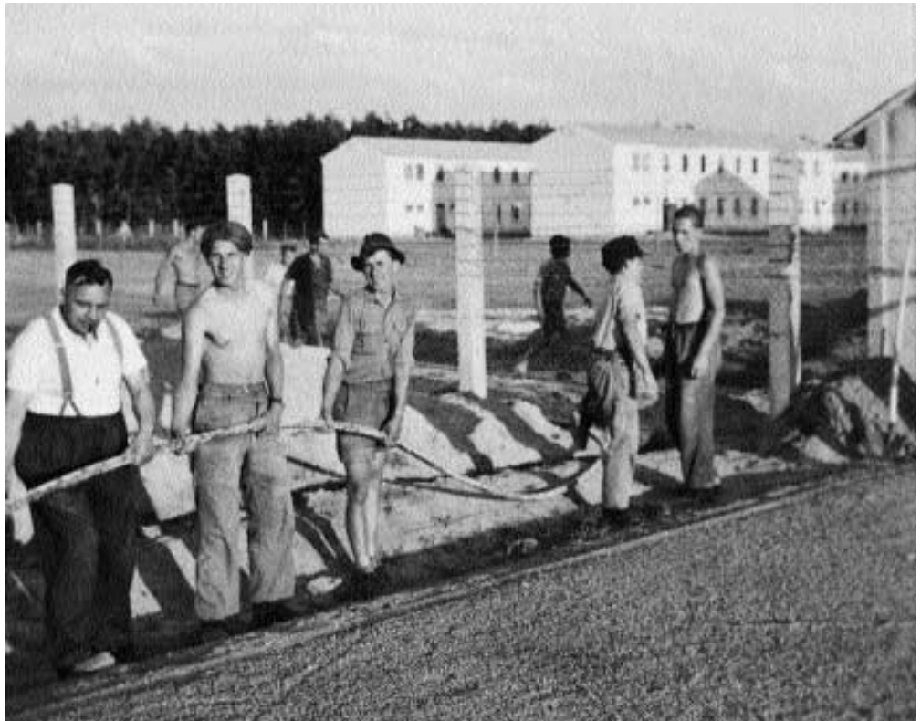
Arbeiter der Firma Singer beim Verlegen von Erdkabeln bei den Kasernen in Neureut, 1952
